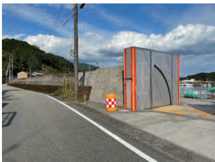
写真3 防波堤のかさ上げ
