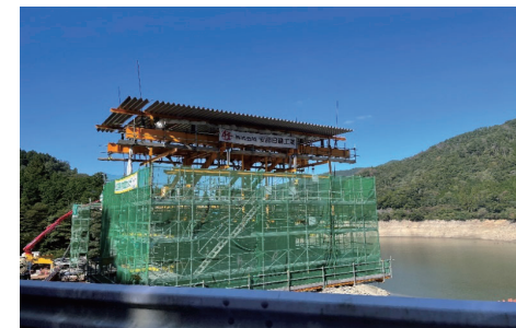
写真 2 道路工事現場
