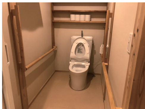
写真3 手すりが追加されたトイレ
