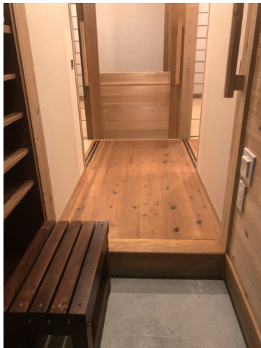
写真7 あえて段差を残した玄関 出所 筆者撮影（2021年9月30日）
