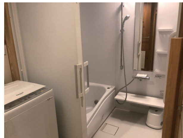
写真5 またぐ高さを抑えた浴室
