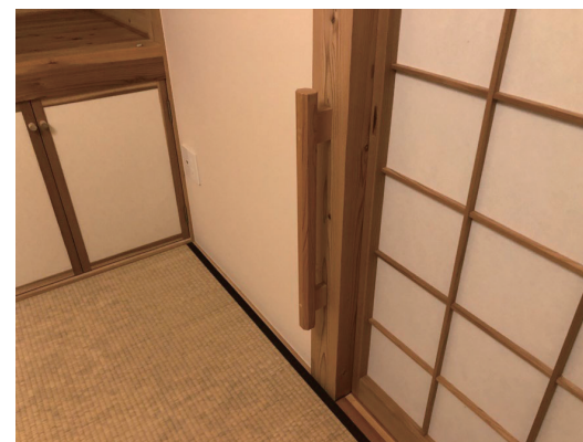
写真4 室内の必要な場所に取り付けた手すり
